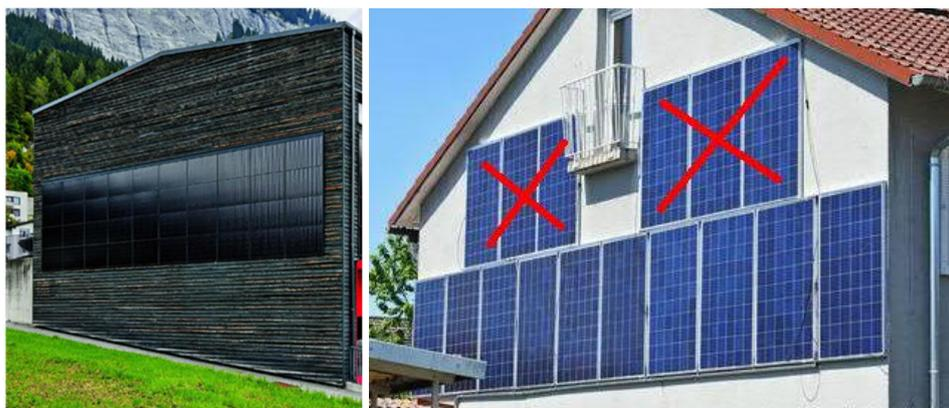
Abbildung 15: Gestaltung / Platzierung von Photovoltaik-Anlagen (Platzierung gemäss Abb. links erwünscht, Platzierung gemäss Abb. rechts nicht erwünscht)
