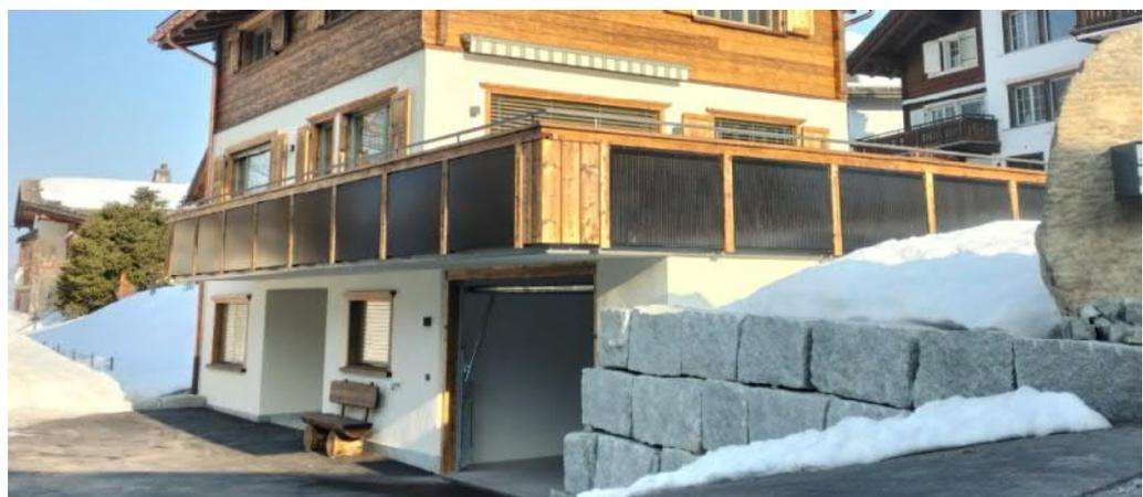
Abbildung 13: Beispiel für die Platzierung der Solaranlage auf Geländer / Brüstungen
