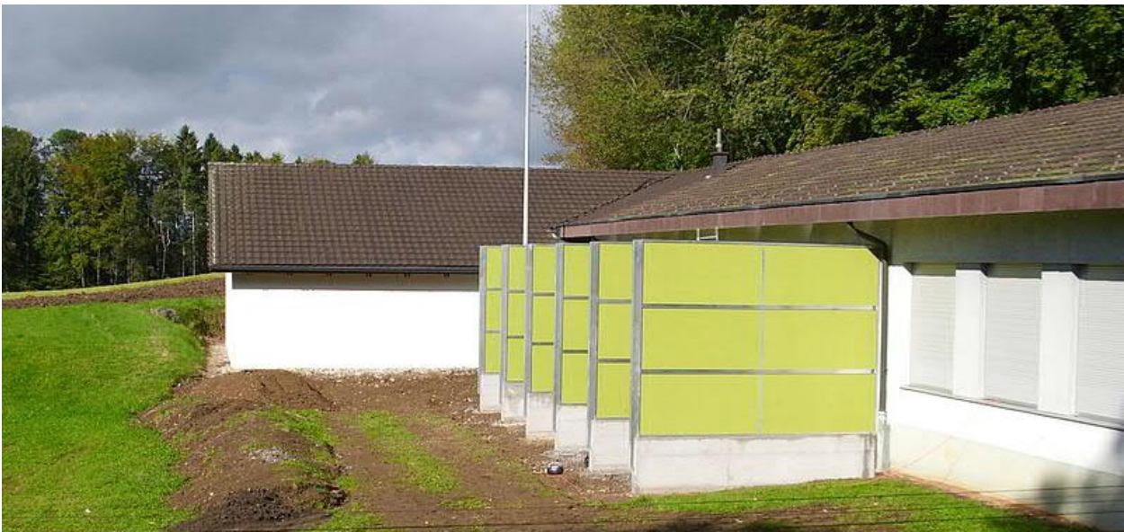
Beispiel Lärmschutzwand, Quelle: suessmann.ch
