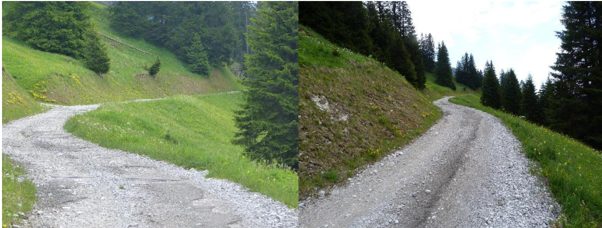
Abb. 4: Aktueller Zustand von Weg 1.
