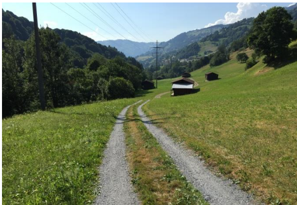
Abbildung 20: Strasse 7 Kiesspurweg.
