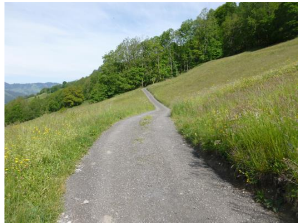
Abbildung 35: Strasse 34 mit Belagsrecycling. Der gleiche Belag ist auch bei Weg 35 verwendet worden.
