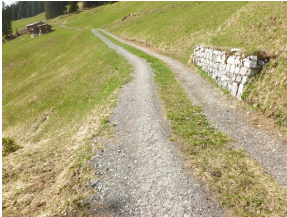
Abbildung 13: Strasse 3 Spurweg.
