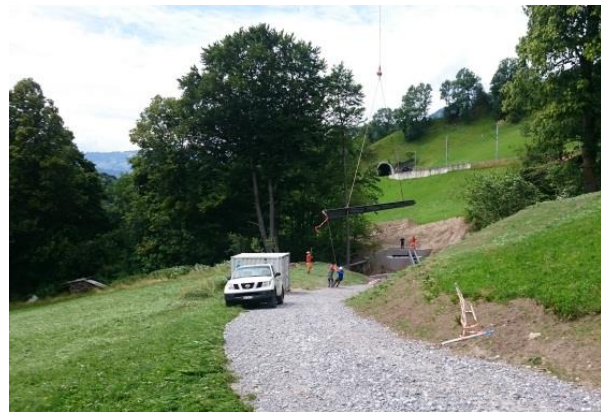
Abbildung 21: Strasse 7 im Bau.
