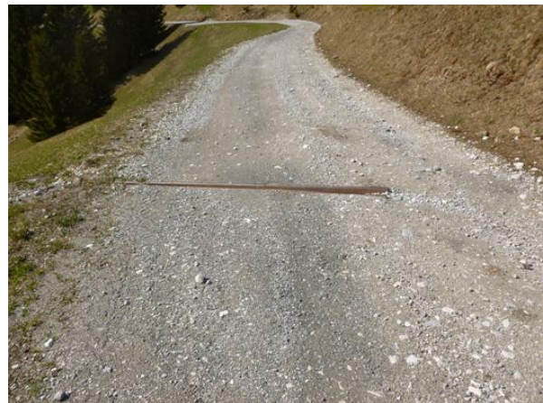
Abbildung 11: Kiesstrasse mit zu kurzem Querabschlag
