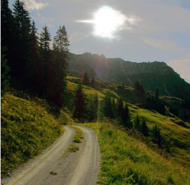
Abbildung 6: Bestehende Erschliessungstrasse unterhalb Zastia.
