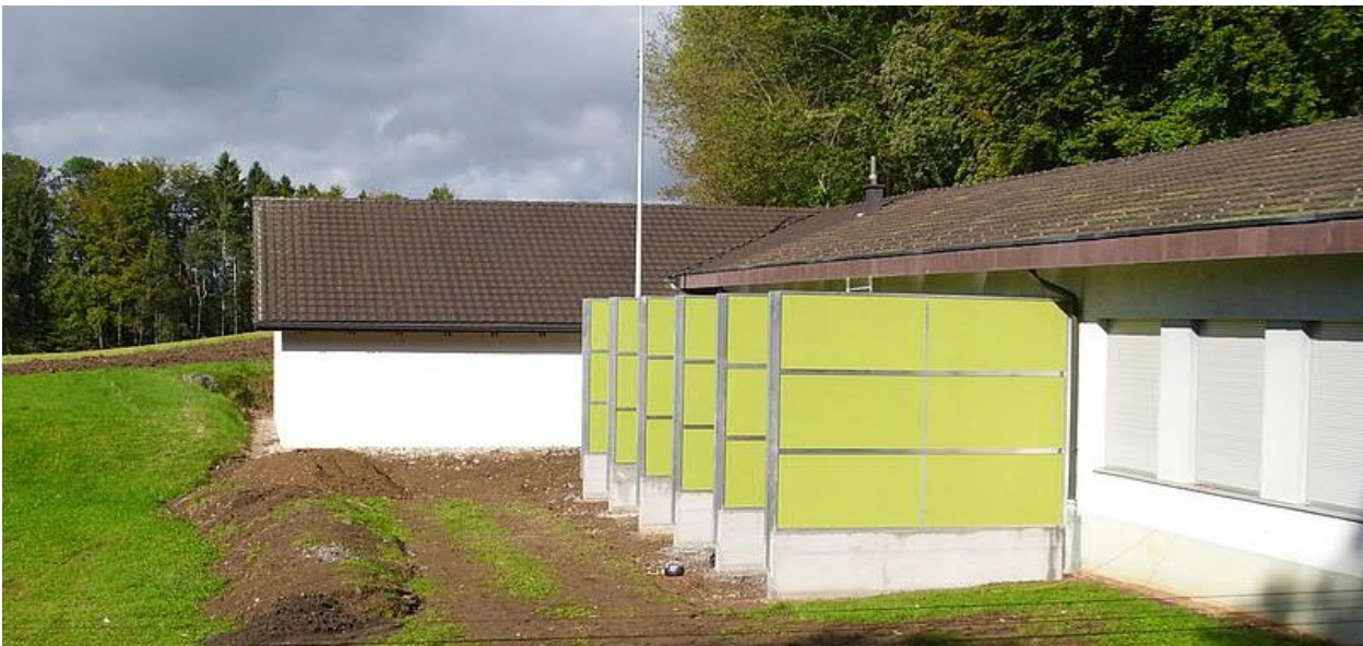
Beispiel Lärmschutzwand, Quelle: suessmann.ch
