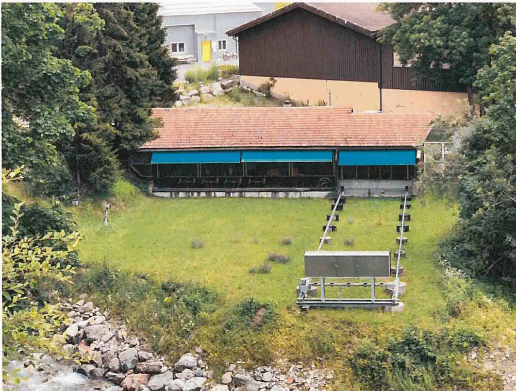
Abbildung 5: Blick von der Kante bei Messpunkt E3 auf die Schiessanlage.
