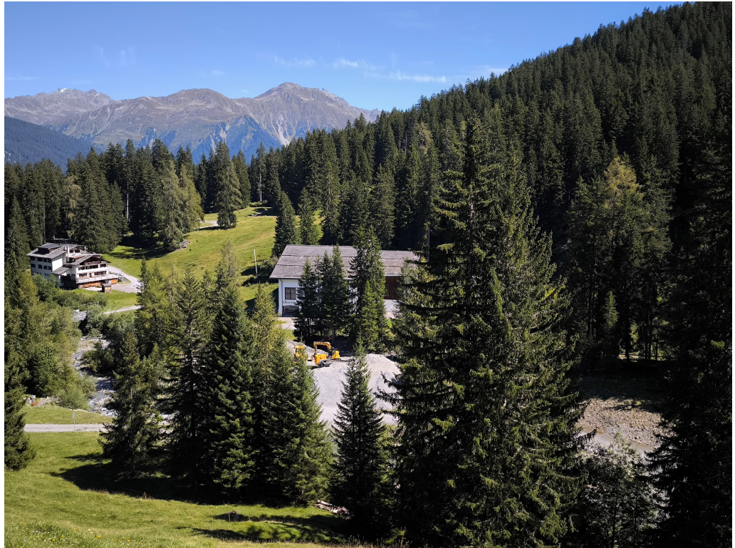
Abb. 30: Foto mit Blick Richtung Talstation der Schiferbahn und Kiesentnahme Schiferbach
