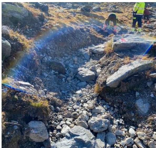
Abbildung 9: Vorher/Nachher Bild einer stark erodierten Stelle auf einem Wanderweg welche mit lokalen Steinen befestigt wurde und damit die weitere Erosion gestoppt ist. (Bilder: Wegunterhalt Gemeinde Silvaplana, ALLEGRA in Zusammenarbeit mit Werk)
