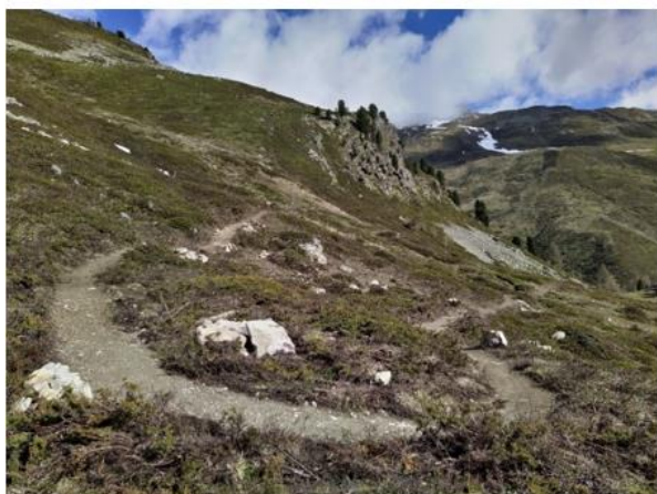
Abbildung 11: Dort wo die Wege bereits stark erodiert, eingefressen sind führt nur der Neubau mit einer Neigung von max. 12% zu einem nachhaltigen, unterhaltbaren Resultat. Der alte Weg kann mit dem anfallenden Material des Neubaus zurückgebaut werden. (Bilder: Via Engiadina Gemeinde Silvaplana, Bau durch ALLEGRA)
