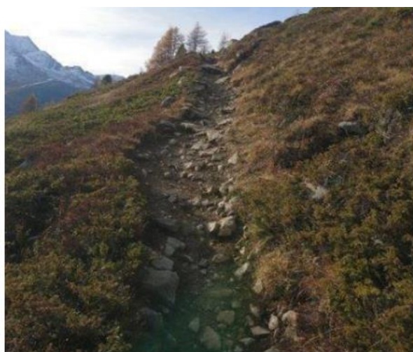
Abbildung 10: Steile, tief eingefressene Wege lassen sich nicht mehr nachhaltig Entwässern und sind deshalb nicht effektiv unterhaltbar
