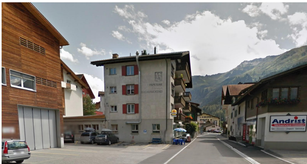
Abb. 3 bestehendes «Haus Brassel» (Streetview)
