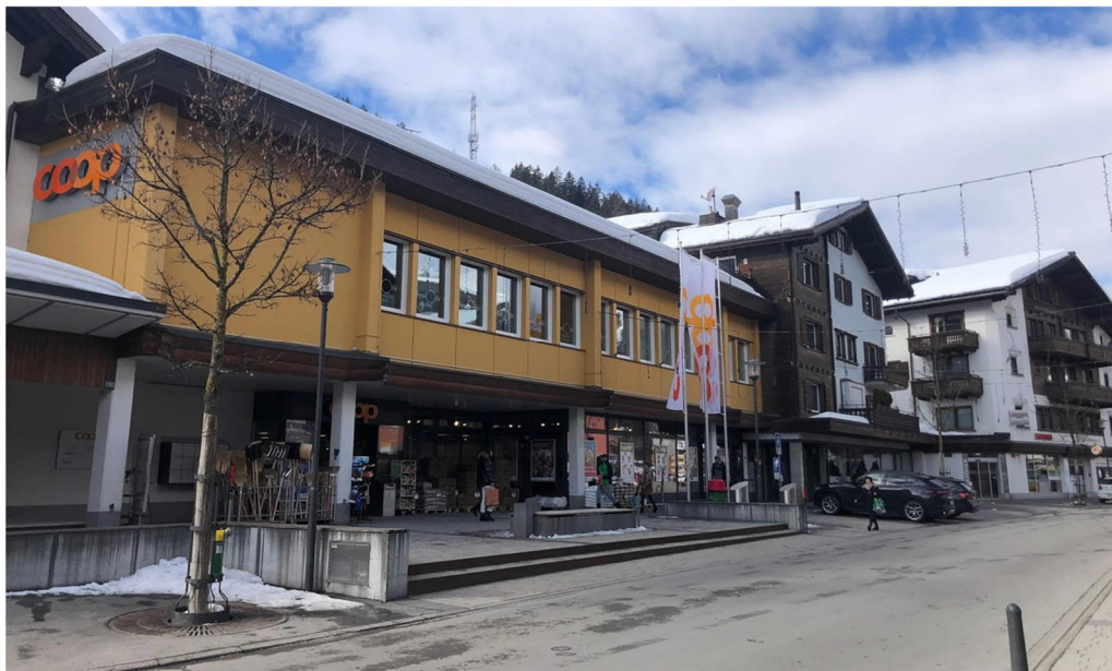
Abb. 1 Foto ins Quartierplangebiet «Coop-Areal», an der Bahnhofstrasse
