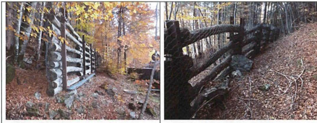
*Abbildung 6: Bestehende Holzpalisaden, welche rückgebaut werden.*
