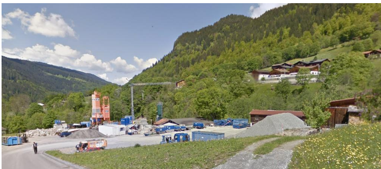
Abb. 3 Übersicht Blickrichtung Baurechtsparzelle Bauunternehmung Vetsch, Westen (Quelle: streetview)
