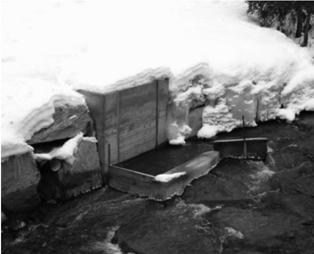
Abbildung 2: Beispiel eines Einlaufbauwerks (Davos).
